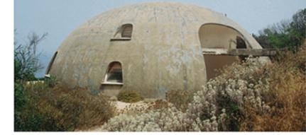
Il fenomeno di degrado più rilevante è la perdita dello strato superficiale della cupola, causata dall'erosione del vento. Questo strato rappresenta un elemento progettuale distintivo che rende la cupola un unicum nel patrimonio delle Binishell, essendo l'unica struttura di questo tipo a presentare tale finitura, ideata dall'architetto in conformità con la visione del regista.
