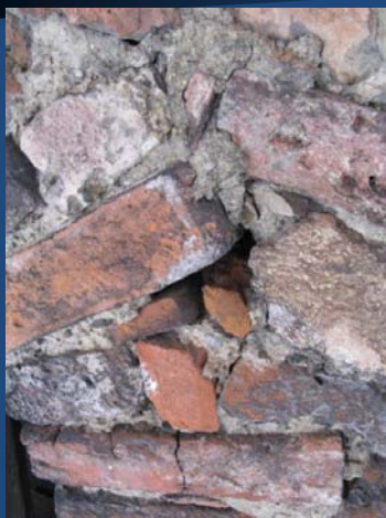
Lato EST Punto di scarico dell'arco sul pilastro angolare (a sinistra) Discontinuità fra le murature del lato Est e il pilastro angolare (sopra)
