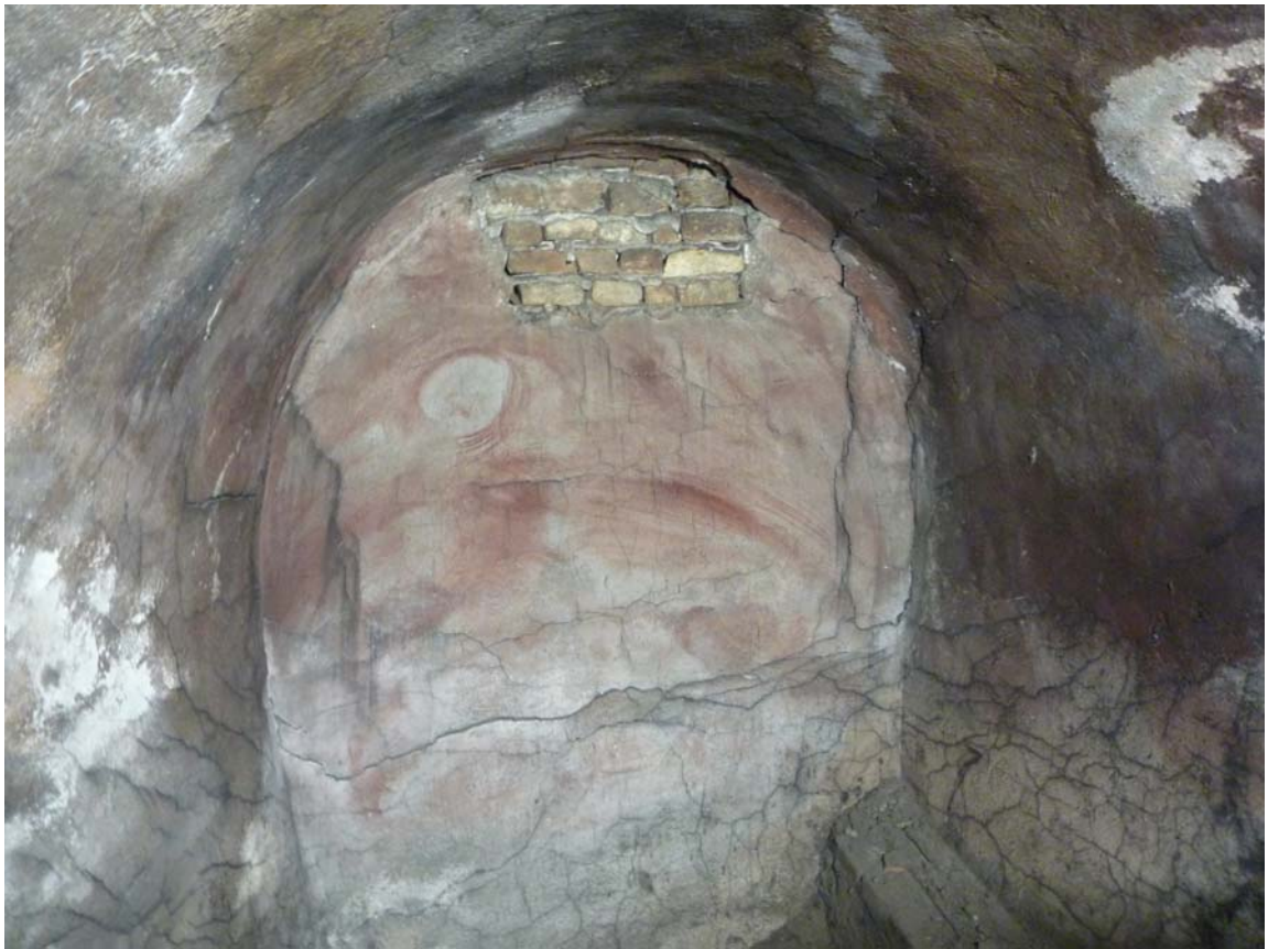
TAMPONATURA DI TIPO B VISTA DALL'INTERNO.
