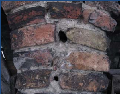
Cavità riscontrate nei pilastrini del lato EST
