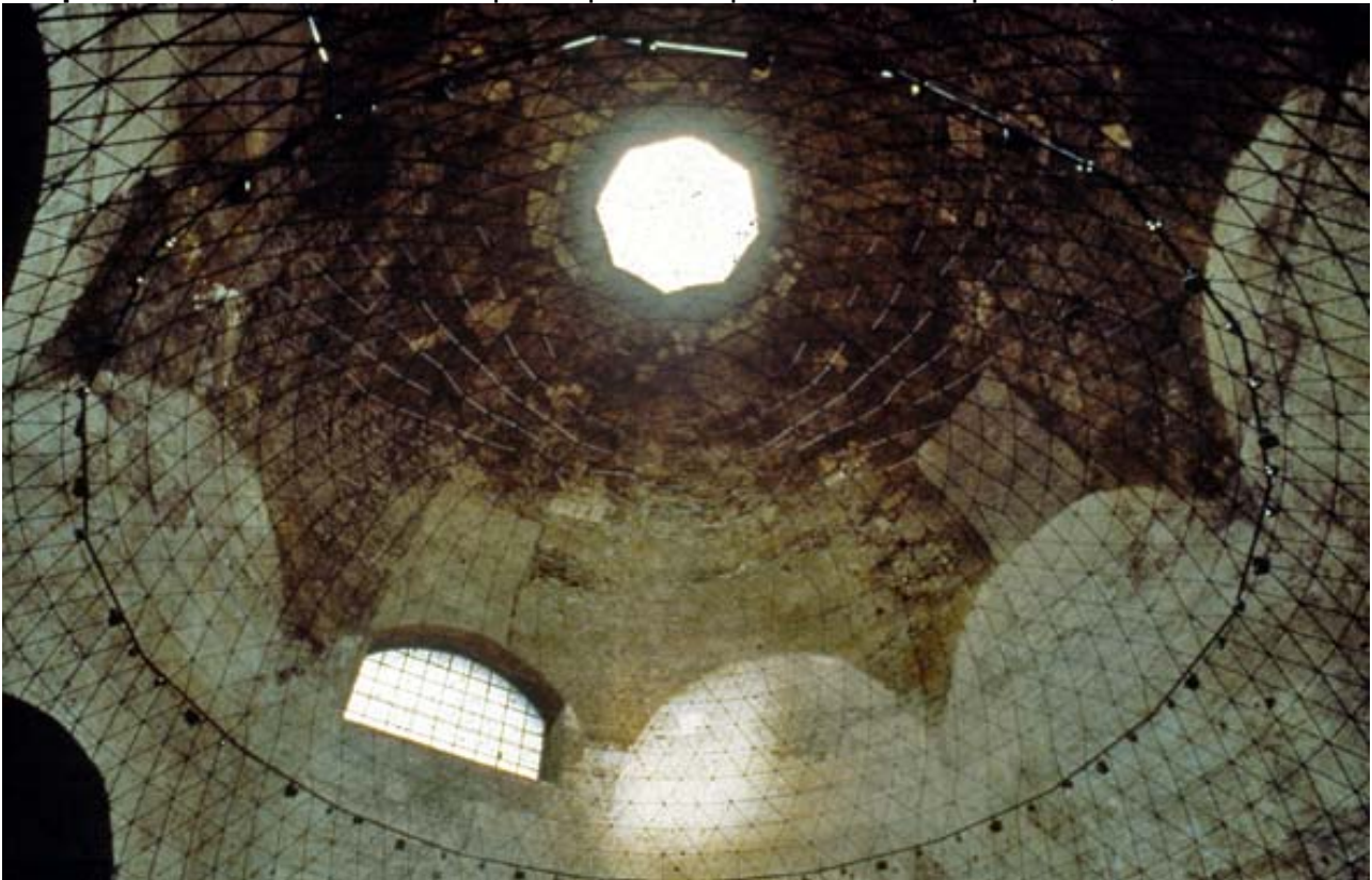
La volta ad “ombrello” dell'aula termale ottagonale
