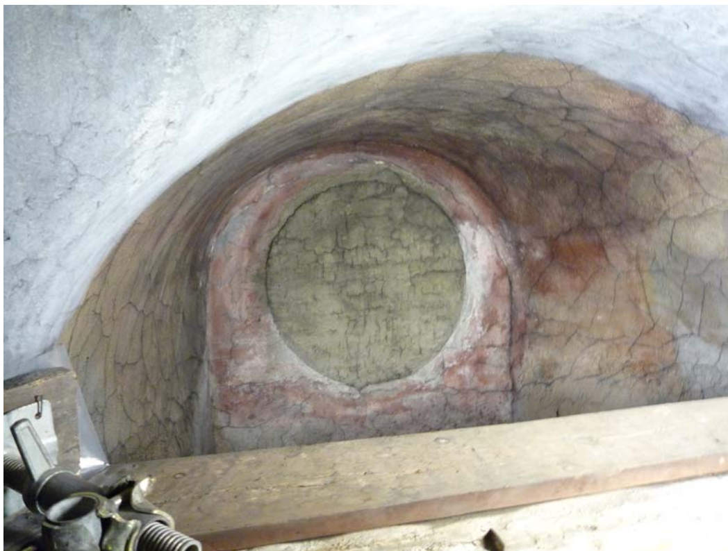
EVIDENZIAMENTO DELLA TRACCIA ELLITTICA SUGLI INTONACI ALL'INTERNO DEL CUPOLINO SOPRASTANTE IL TAMBURLO NELLE TAMPONATURE DI TIPO A.
