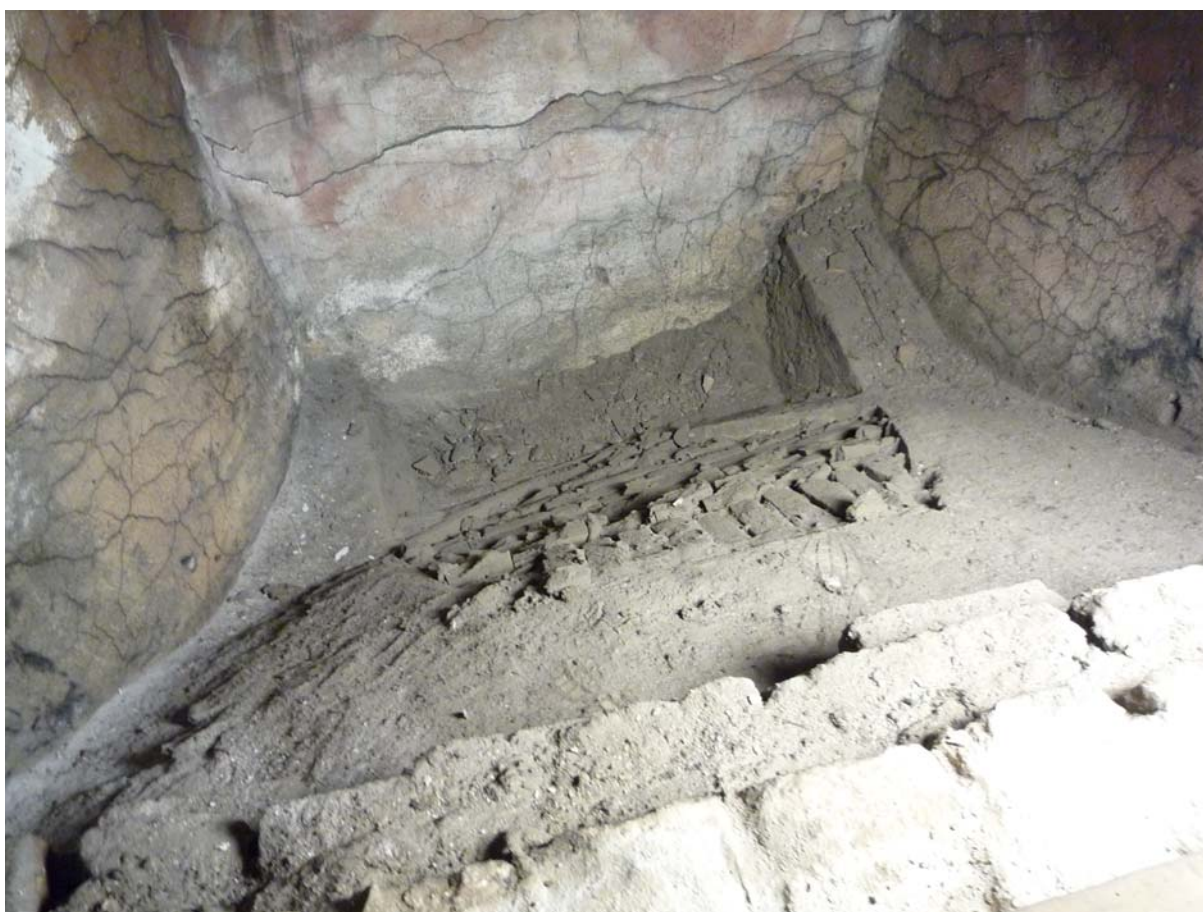
ESTRADOSSO DELLA PORZIONE DI CUPOLA COMPRESA TRA LE COSTOLATURE CON EVIDENZIAMENTO DEL PENTAGONO TAMPONATO.
