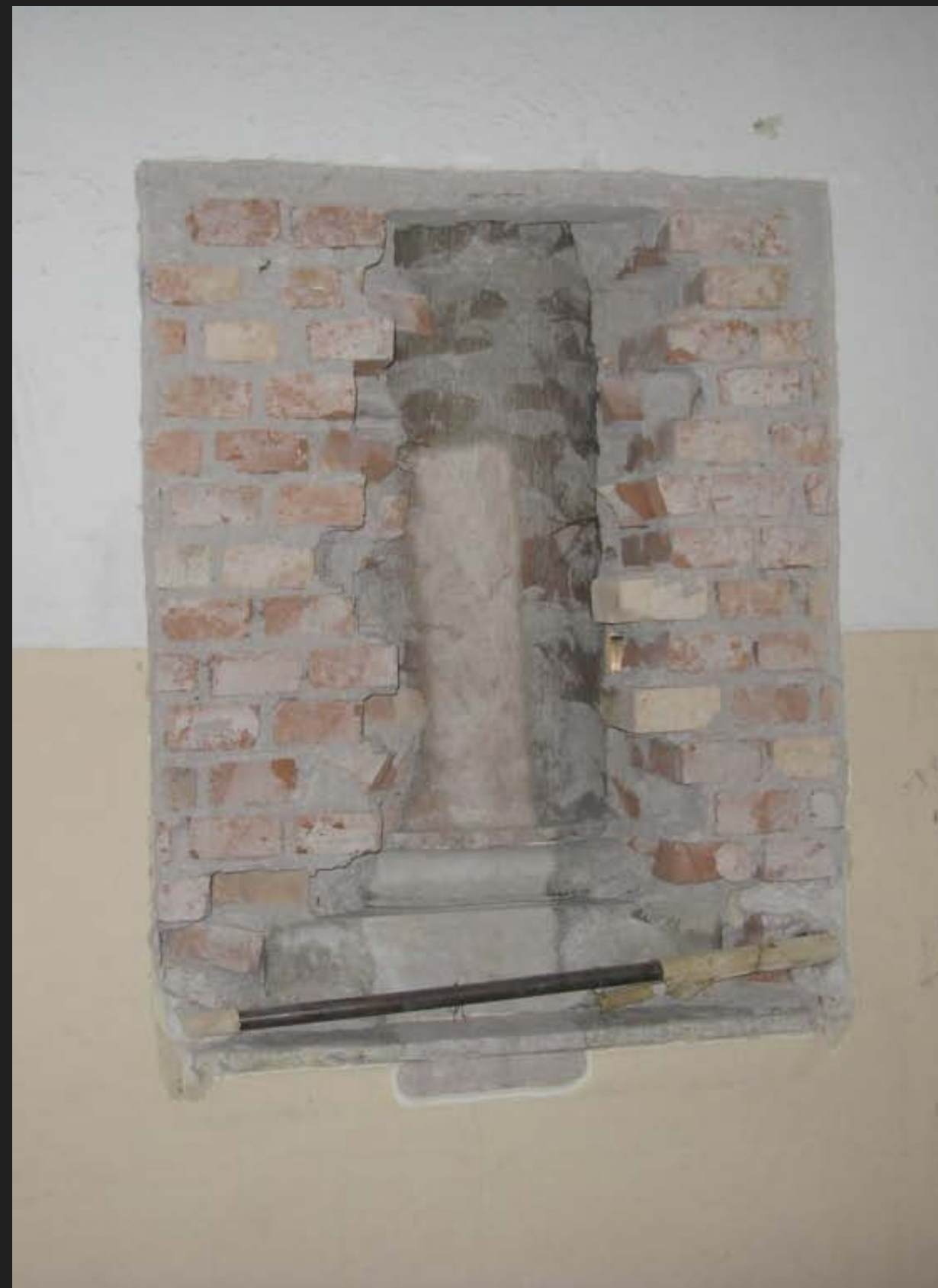
Tamponamento del loggiato: verifica del reale spessore della muratura di tamponamento realizzata nel 1927.
