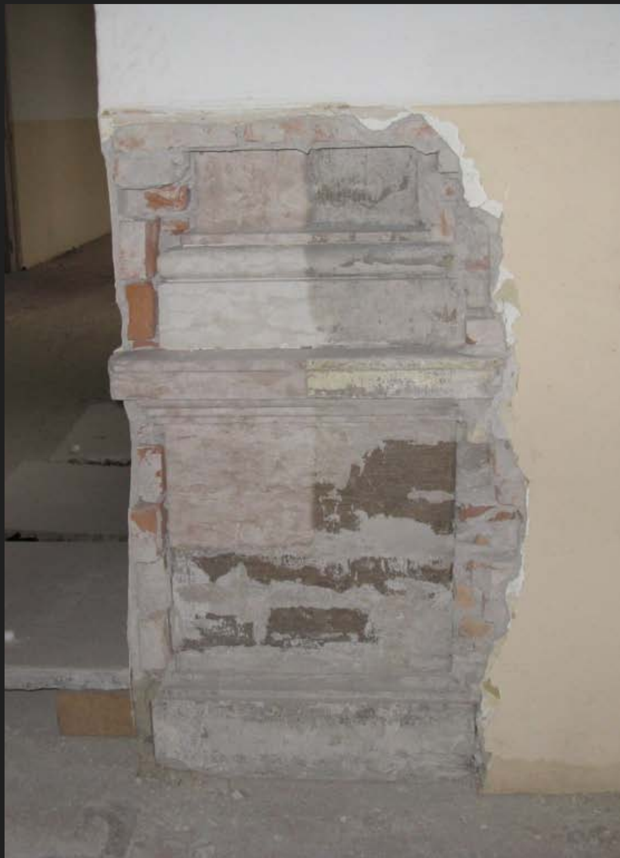
Tamponamento del loggiato: verifica del reale spessore della muratura di tamponamento realizzata nel 1927.
