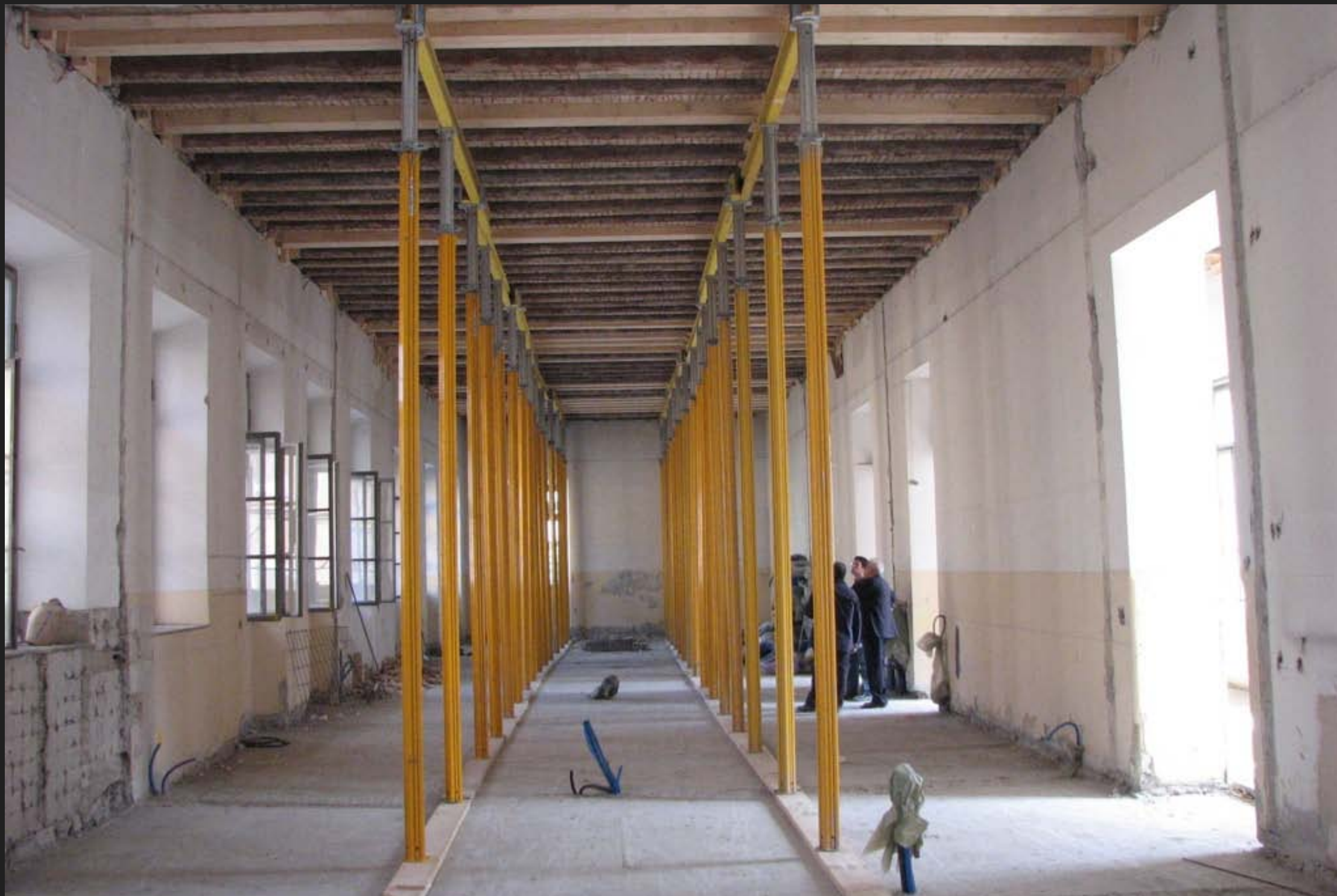
Solaio in legno: rinforzo mediante soletta collaborante in c.a.: puntellazione per il getto.
