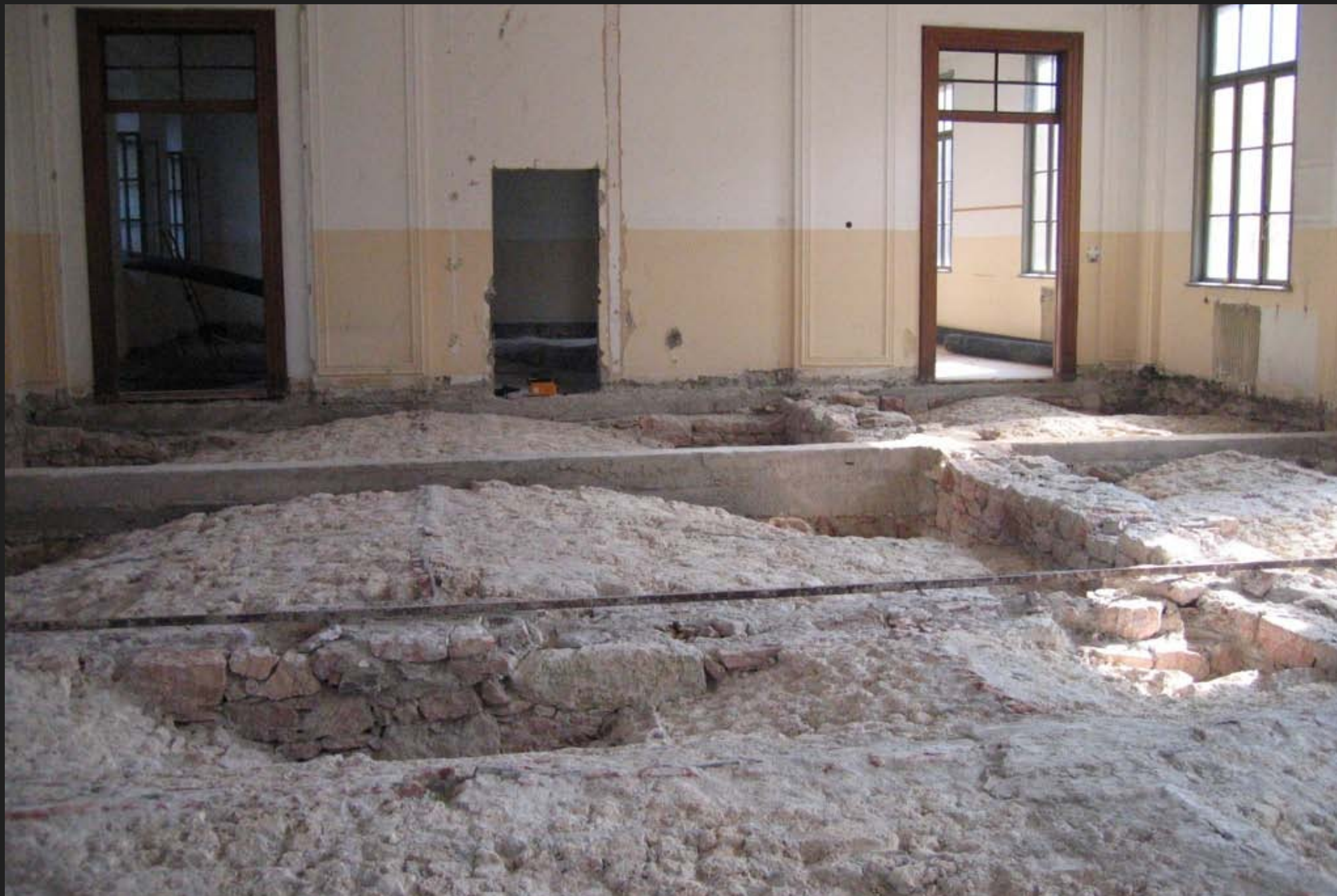
Catene in ferro realizzate nel 1865 e in c.a. realizzate nel 1927.
