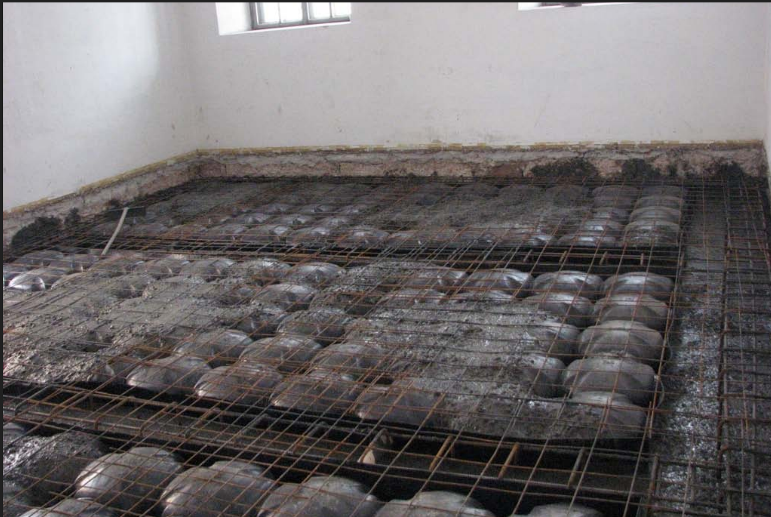
solai al piano terra: realizzazione di vespai aerati
