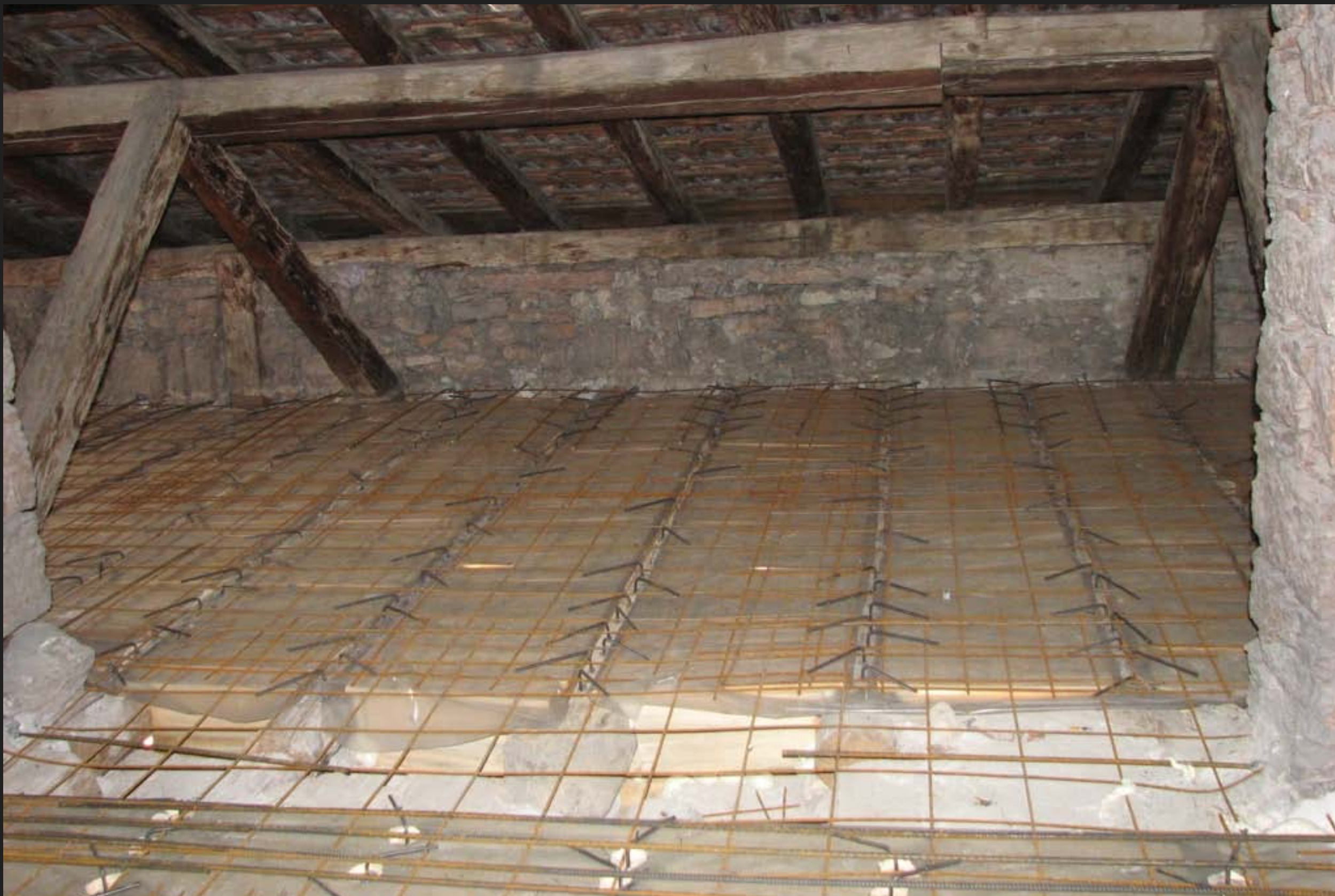
Solaio in legno: rinforzo mediante soletta collaborante in c.a.: posa dei connettori e della rete elettrosaldata.
