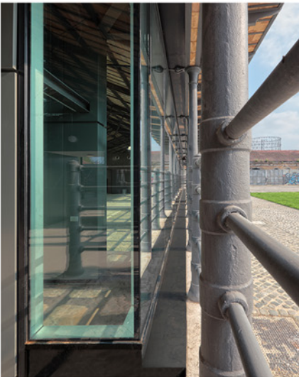
Il nuovo involucro vetrato con montanti interni indipendenti dalla struttura originaria in ferro e ghisa
