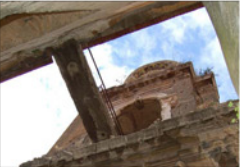
Passerella in calcestruzzo armato, 2008
