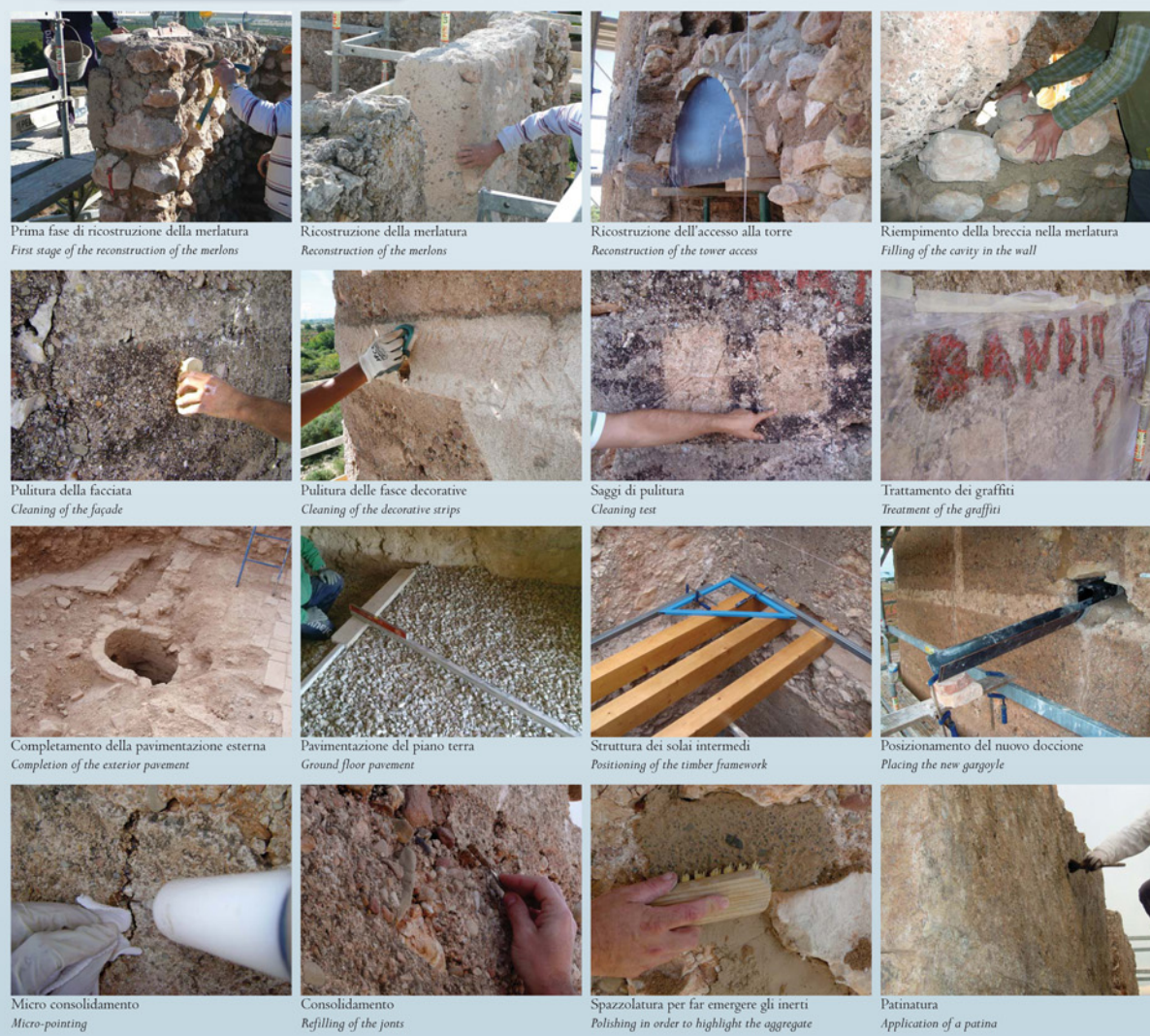
FASI DI CANTIERE RESTORATION WORK
